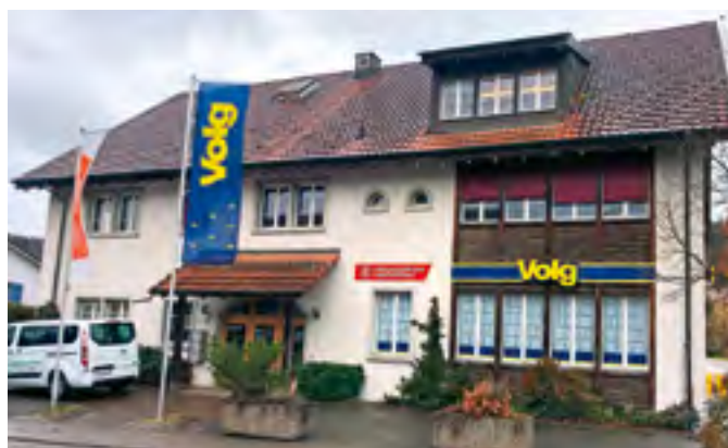
Seit Ende Dezember ist in der ehemaligen und nicht mehr genutzten Werkstatt des Verbandsgebäudes ein Volg-Laden in Betrieb.
